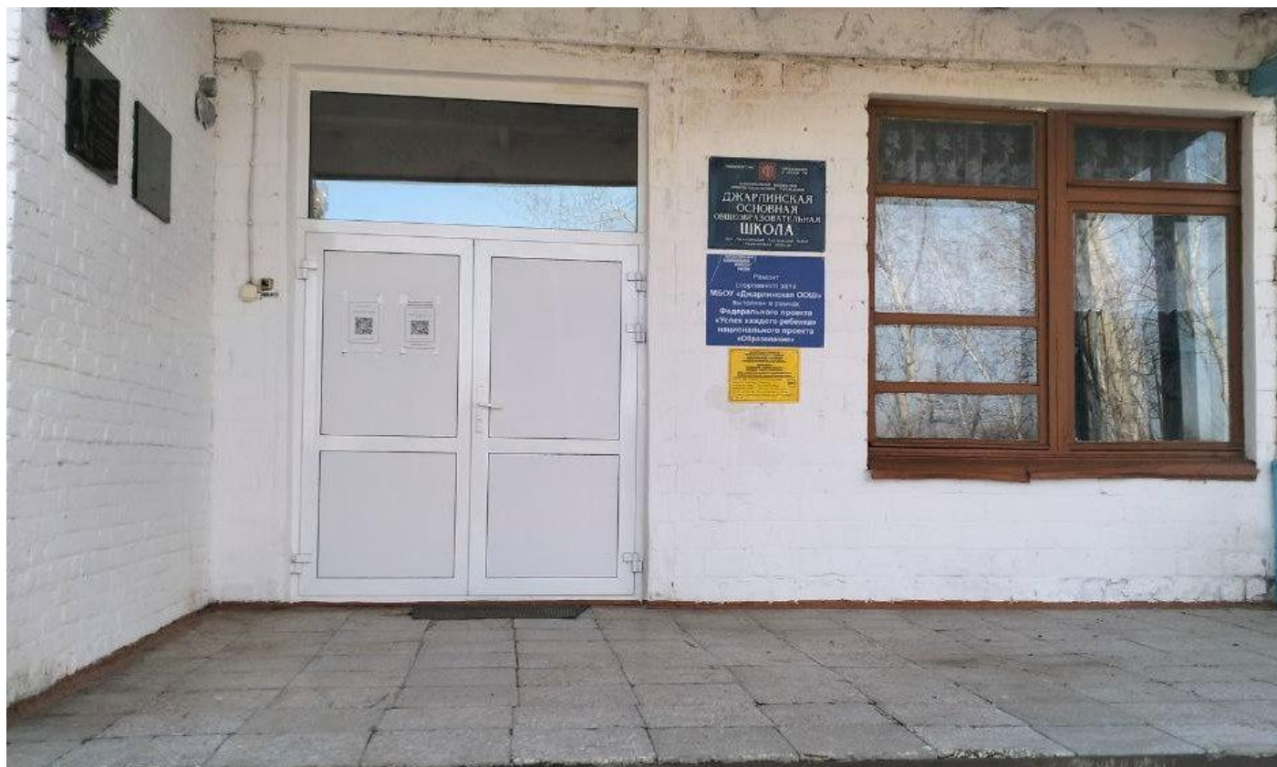
Входная площадка (перед дверью)
