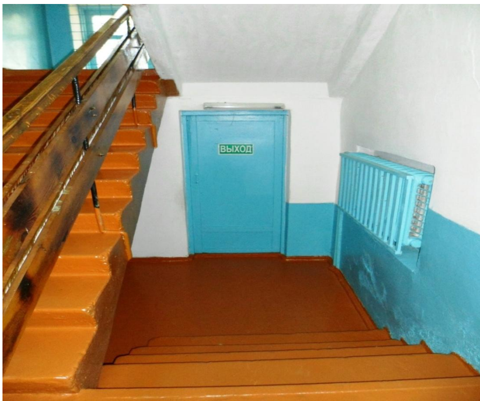
Пути эвакуации (пожарный выход)
